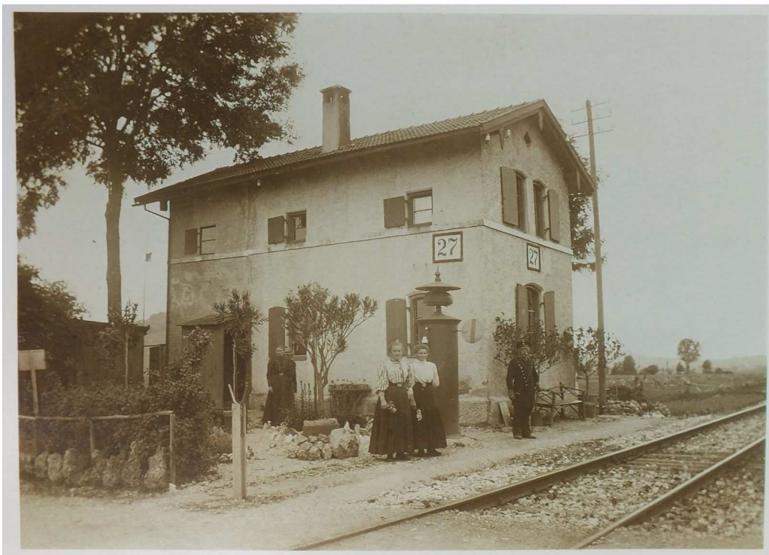
Mantelbude mit 2 Glocken und Fallscheibe an einem Bayrischen Bahnübergang, ca. 1910
